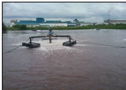
บ่อเติมอากาศ / บ่อที่ใช้ผลิตภัณฑ์ ทีพีไอ บำบัดน้ำเสีย
